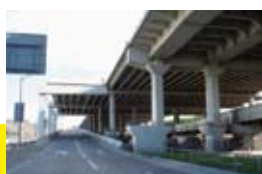
Дорожное строительство (крепление сборных железобетонных элементов)
